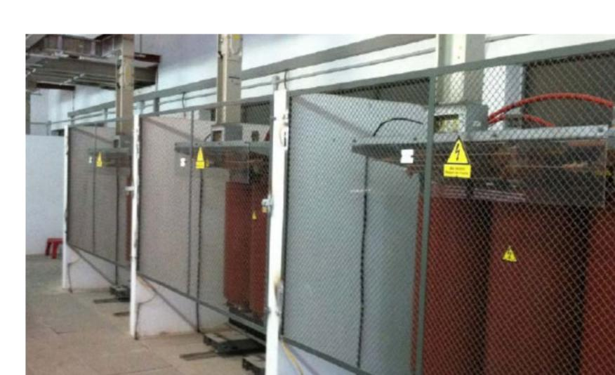
Figura 2. Sistema de tuberías electrificadas y transformadores secos.
