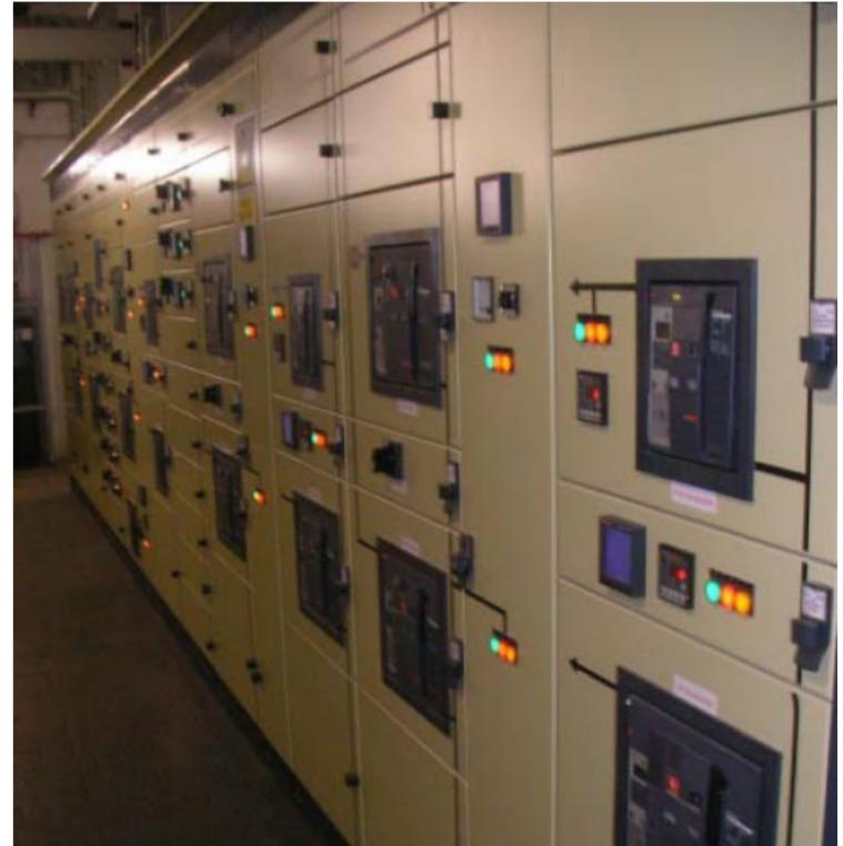
Figura 3. Sistema de control y monitorización en tablas generales
