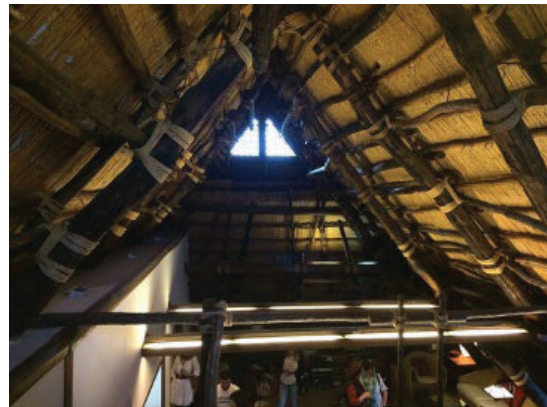
Imagen 12. Cubierta con paja y madera Image 12. Wood and Straw roof
