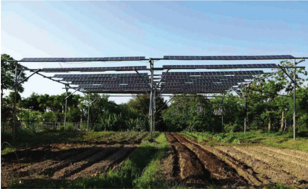
Figura 1. Prototipo de Agrivoltaica o "reparto solar", por Akira Nagashima [3] Agrivoltaics or "Solar Sharing" prototype, by Akira Nagashima [3]
