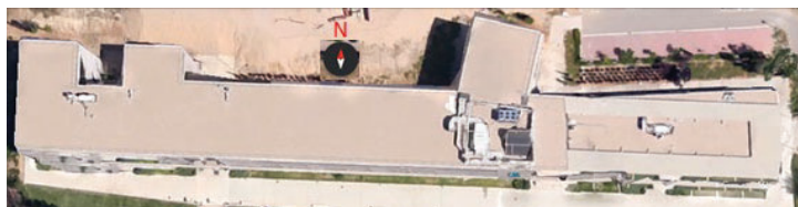
Cubierta de edificio / Building roof (Fuente / Source: Google Earth).
