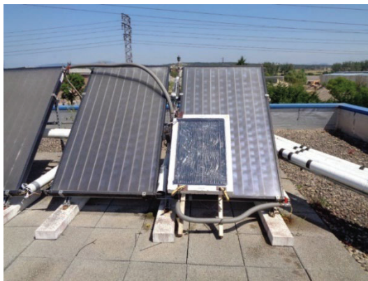
Figura 8. Instalación del demostrador para proceder a su validación.
