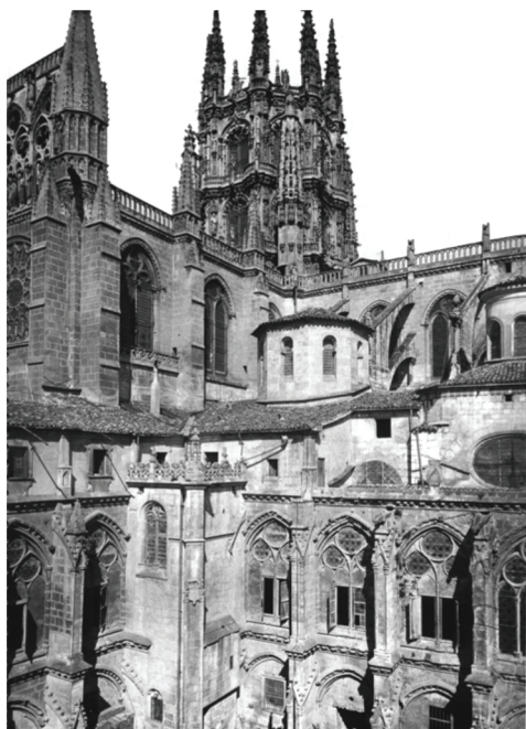
Imagen. 2: Claustro cuando aún contaba con el piso superior añadido y tracerías cegadas.
