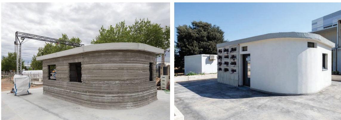
Figura 3. Proceso de impresión y resultado final de la casa impresa en 3D
