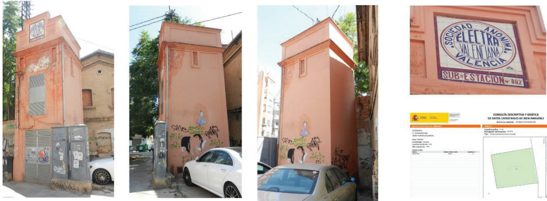
Imagen 4. Torre de ELECTRA VALENCIANA. Fuente: Base de datos del catastro [7]. Fotografías de los autores Image 4. ELECTRA VALENCIANA tower. Source: Cadastre database [7]. Credits: the authors
