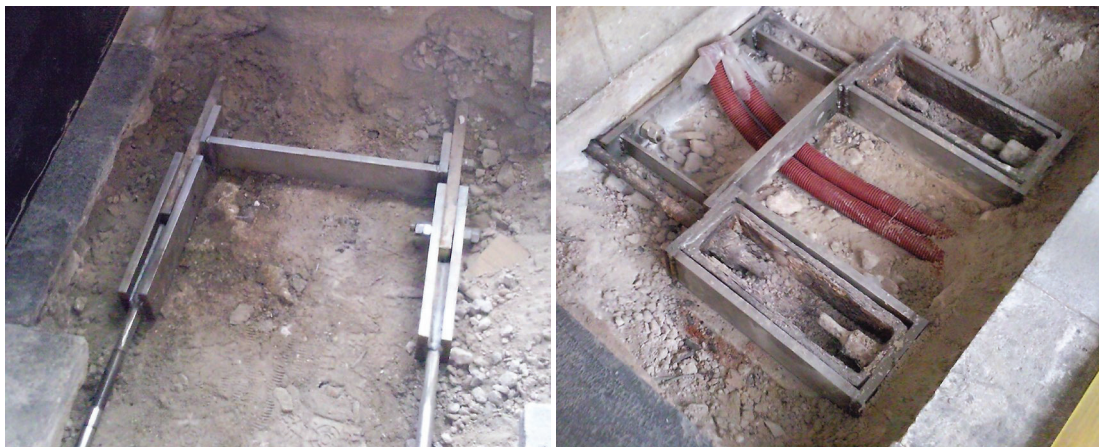
Imagen 7. Estado final del sistema de atirantado. Image 7. Final State of the cable-stayed system
