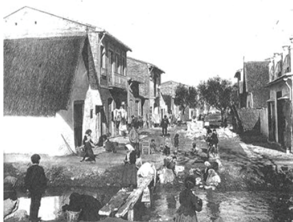
Imágenes 5. Acequia el Gas - calle progreso. Fuente: Extraída de Sanchis Pallarés A. (1997) Image 5. Acequia el Gas - progress street. Source: Sanchis Pallarés A. (1997)
