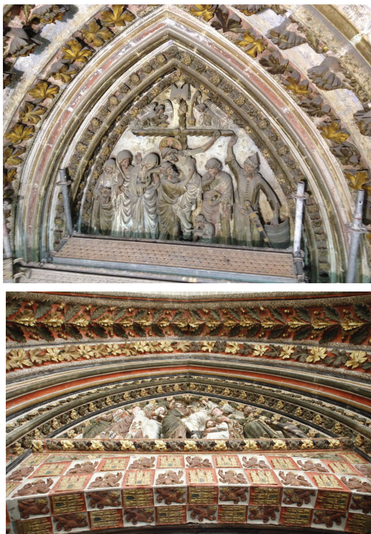
Imagen 12. Estado inicial y final de la portada de acceso a la Capilla de santa Catalina. Image 12. Initial and final state of the access to the Chapel of Santa Catalina
