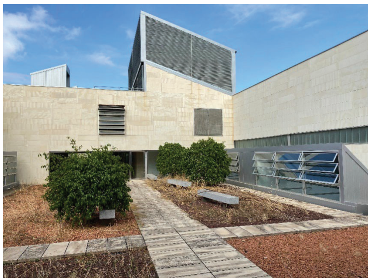
Imagen 1. Cubierta ajardinada transitable de estudio. Image 1. Passable green roof to study.
