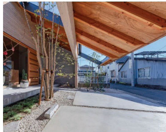
Imagen 13. Cubierta de madera volada Image 13. Cantilevered wooden roof
