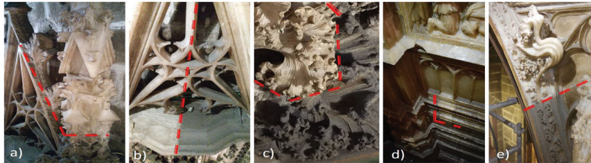
Figura 5 (a-e). Detalle de las pruebas de limpieza realizadas con el fin de valorar y decidir la metodología de trabajo más eficaz y óptima para el tratamiento de la obra (principio de seguridad e inocuidad).
