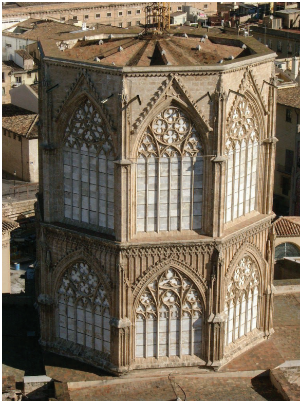
Imagen 6. Cimborio Image 6. Dome
