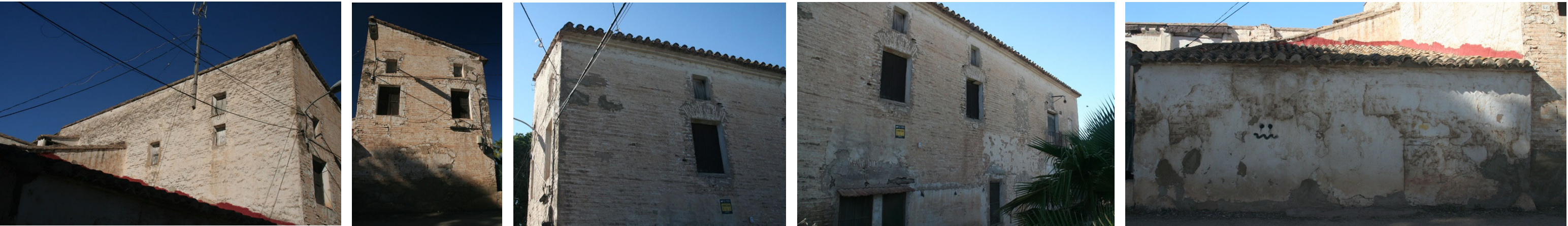
Imagen 3. Muros de carga con distintos tipos de mampostería. Image 3. Load bearing walls with different masonry typologies. © I. Álvarez
