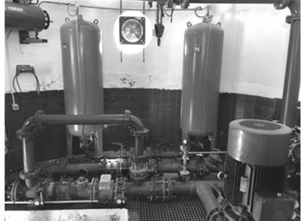
Figura 4. Instalación hidráulica proyectada Image 4. Projected hydraulic installation
