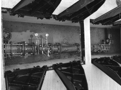
Figura 5. VRP de sectorización Image 5. Sectorization VRP
