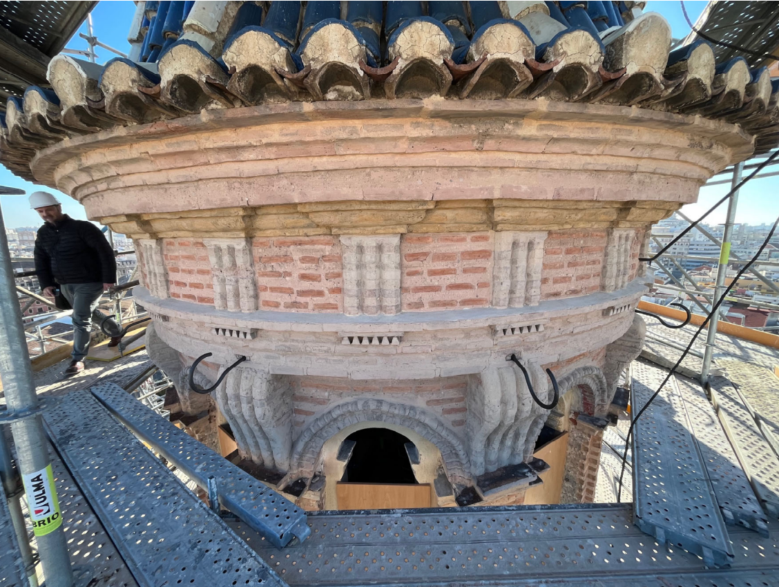
Imágenes 6, 7, 8, 9. Detalle de moldura de ladrillo aplantillado en la ventana de la linterna. Moldeado de la ménsula de linterna con mortero. Detalle del arquitrabe del tambor. Coronación de la linterna con aplantillado y fingiendo piedra algunos elementos.
