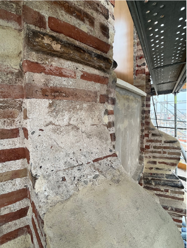
Imágenes 6, 7, 8, 9. Detalle de moldura de ladrillo aplantillado en la ventana de la linterna. Moldeado de la ménsula de linterna con mortero. Detalle del arquitrabe del tambor. Coronación de la linterna con aplantillado y fingiendo piedra algunos elementos.
