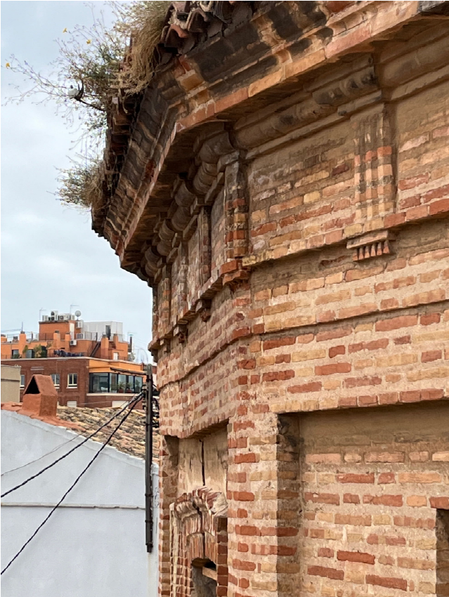
Imágenes 6, 7, 8, 9. Detalle de moldura de ladrillo aplantillado en la ventana de la linterna. Moldeado de la ménsula de linterna con mortero. Detalle del arquitrabe del tambor. Coronación de la linterna con aplantillado y fingiendo piedra algunos elementos.
