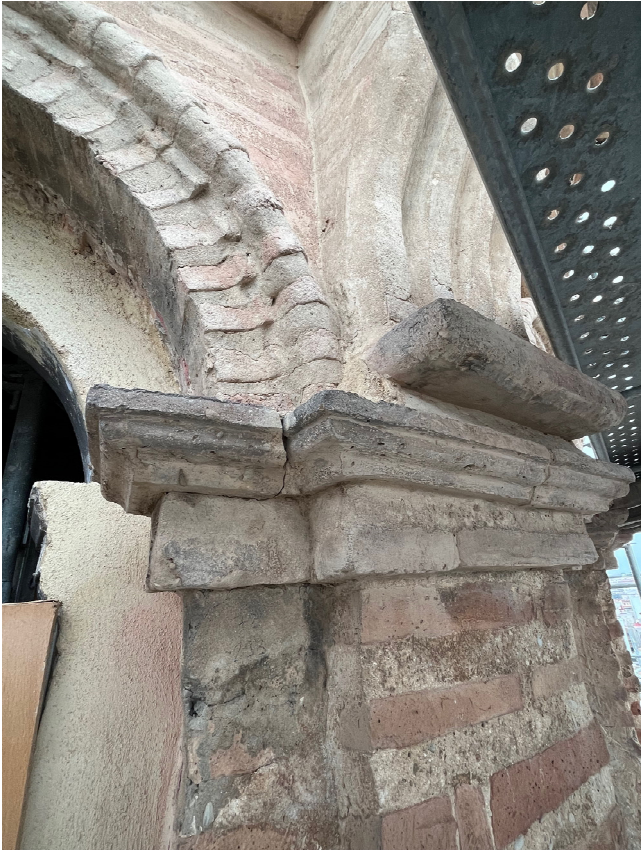
Imágenes 6, 7, 8, 9. Detalle de moldura de ladrillo aplantillado en la ventana de la linterna. Moldeado de la ménsula de linterna con mortero. Detalle del arquitrabe del tambor. Coronación de la linterna con aplantillado y fingiendo piedra algunos elementos.
