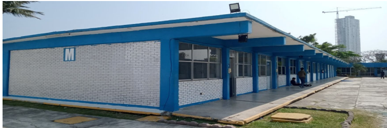
Imagen 1. Edificio M en el TecNM Campus Boca del Río. / Image 1 . Building M at TecNM Campus Boca del Río
