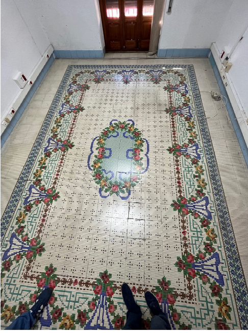
Imágenes 3-7. Fotografías del estado actual de los pavimentos. Tal y como se observa son pavimentos hidráulicos de bella factura, en estilo modernista, historicista y art decó. Images 3-7. Pictures of the current state of the pavements. As can be seen, they are beautifully made hydraulic pavements, in modernist, historicist and art deco styles.
