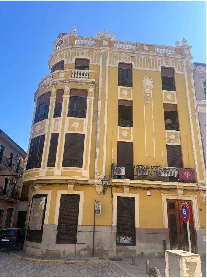
Imagen 1. Vistas de la fachada en la c/ Sant Roc. Image 1. View of the façade of Sant Roc Street.
