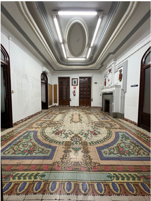
Imágenes 3-7. Fotografías del estado actual de los pavimentos. Tal y como se observa son pavimentos hidráulicos de bella factura, en estilo modernista, historicista y art decó. Images 3-7. Pictures of the current state of the pavements. As can be seen, they are beautifully made hydraulic pavements, in modernist, historicist and art deco styles.
