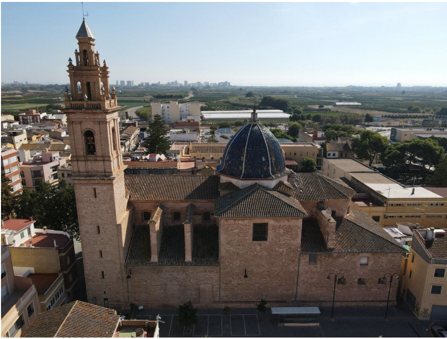
1. Fotografía aérea de la fachada oeste año 2020 con el campanario (Jorge García-Valdecabres, Vicent F. Zuriaga Senent 2023) 1. Aerial photograph of the west facade in the year 2020 with the bell tower
