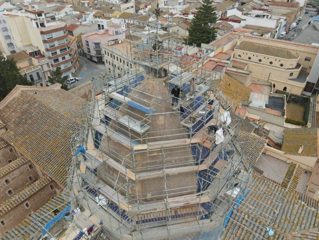
3. Vista en perspectiva de las obras. Febrero de 2021 (Luis Cortés Meseguer, José Pardo Conejero 2023) 3. Perspective view of the works. February 2021.
