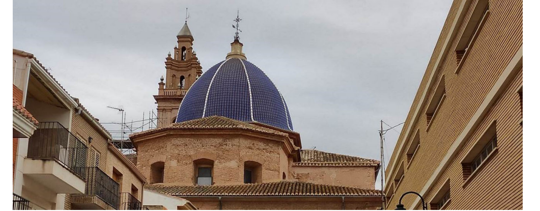
6. Vista final de la intervención desde la plaza de Jesús. Abril de 2021(Luis Cortés Meseguer, José Pardo Conejero 2023) 6. Final view of the intervention from Plaza de Jesús. April 2021.
